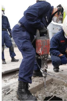
圖 25 使用電鑽破壞混凝土
