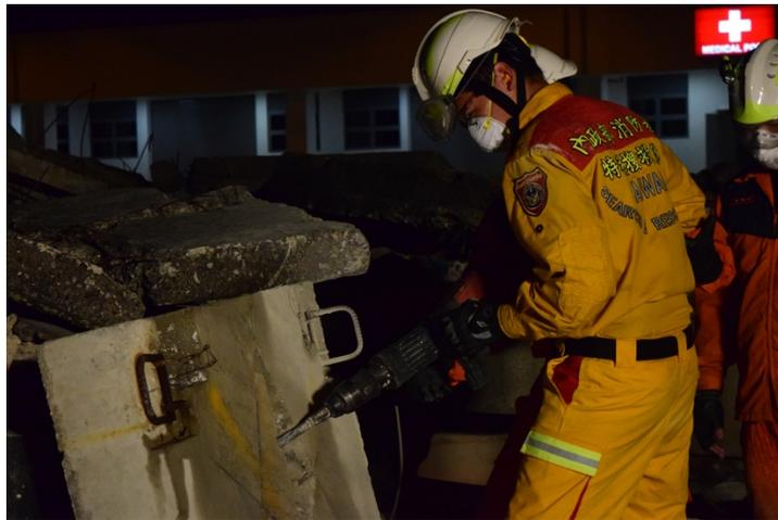
圖 40 使用電鑽進行混凝土破壞
