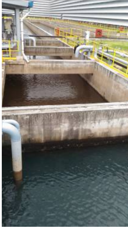
室外煤場煤水收集水池及處理後可再利用之清水池
