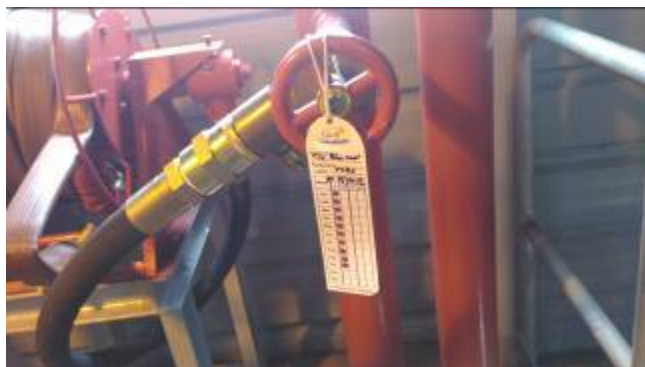
快速消防水帶及檢查卡（打洞式每月一次）
