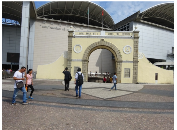
圖 26 葡萄牙人建造關閘拱門
