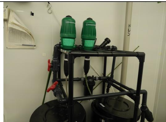
植物工廠內養液汲取系統(定比稀釋器)
