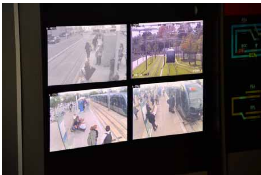
圖 60. 波爾多公共運輸(輕軌)行控中心現場 CCTV 監控畫面
