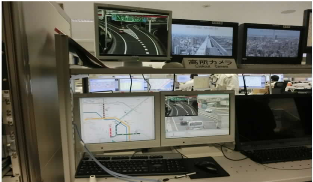
圖 10 日本東京消防廳勤務指揮中心高空攝影機拍照監視設備
