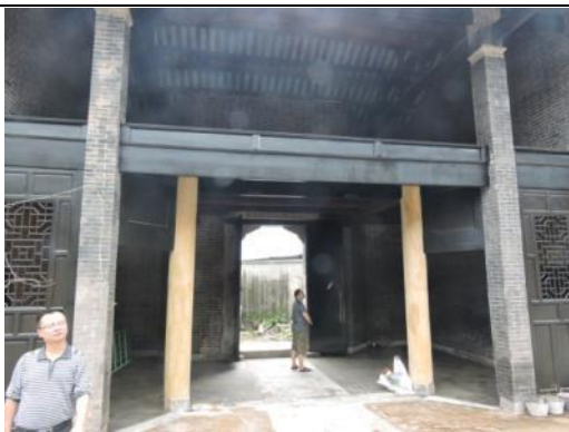
本館於抗戰時期白沙之辦公處 鄧家大院入口
