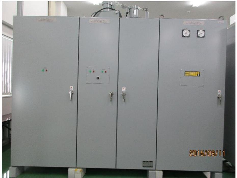
圖(十六-a)通霄新一機氣渦輪發電機 AVR 相關盤面
