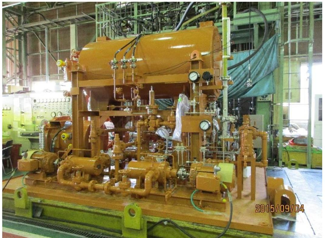
圖(九.b)通霄一號機汽機發電機封油系統進行管路油洗
