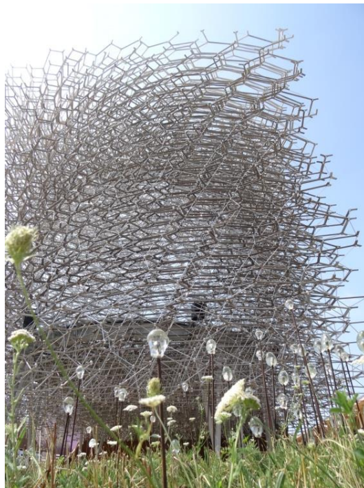
圖一、鋁管及鋼片搭建的蜂巢(14 米高)
