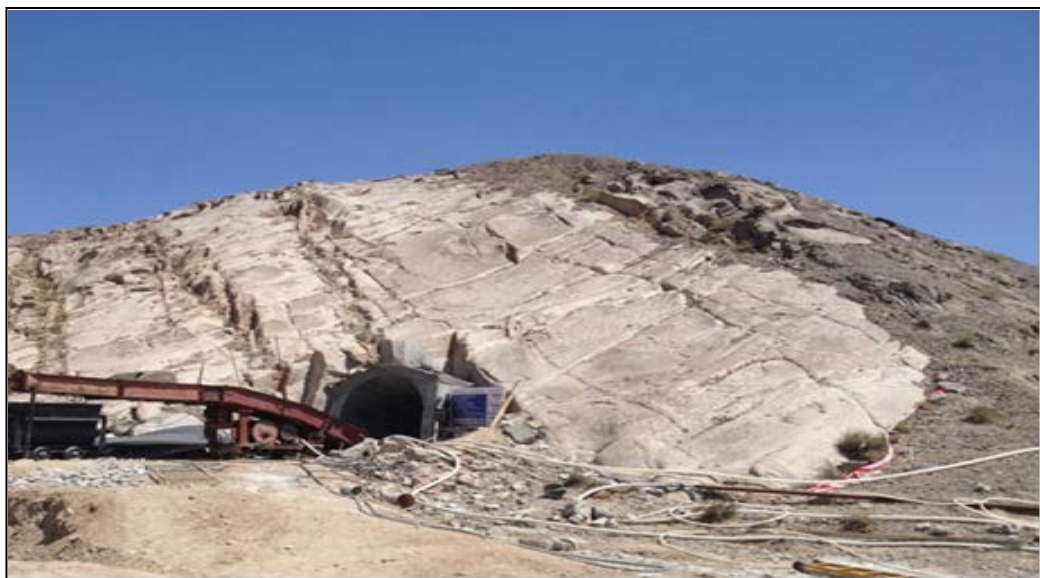
圖 19 十月井斷裂帶的坑探設施洞口
