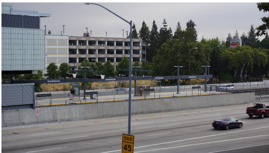
圖 35 舊金山捷運 BART 車站
