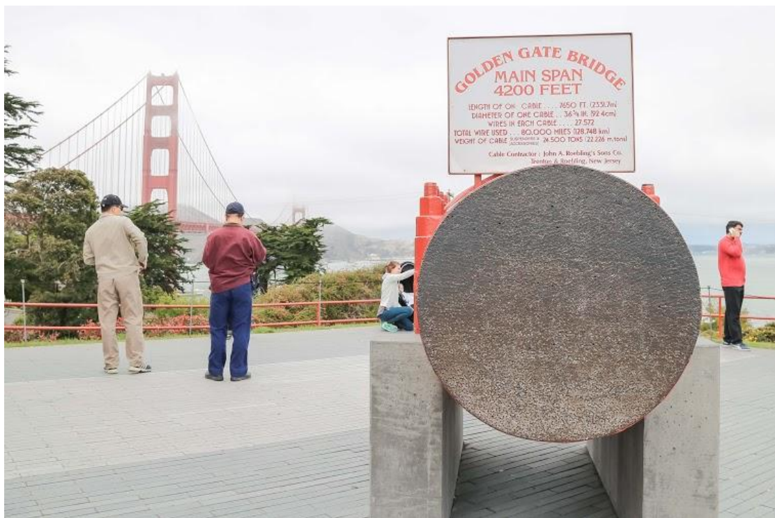
圖12 從舊金山金門大橋主跨鋼纜淨斷面
