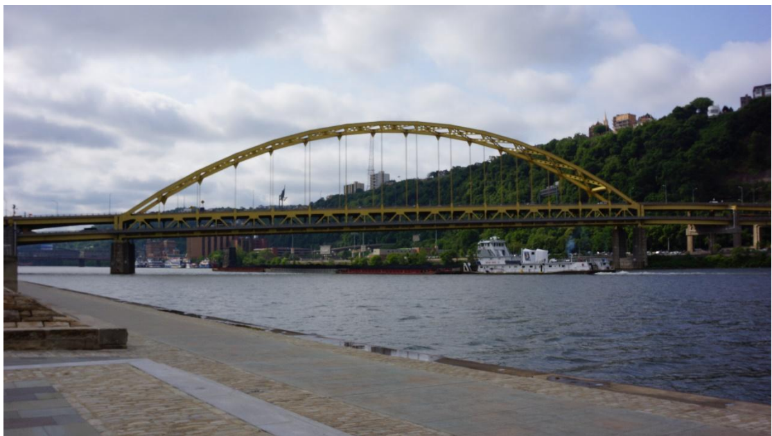
圖 15 匹茲堡 Fort Pitt Bridge
