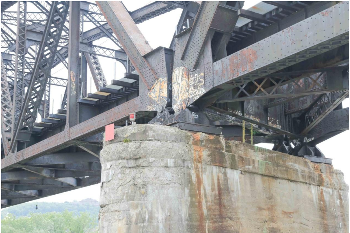
圖 44 匹茲堡當地鐵路橋墩剝落且防落裝置不足之情形
