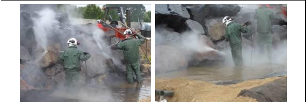
高溫高壓水槍沖洗岩石示範
