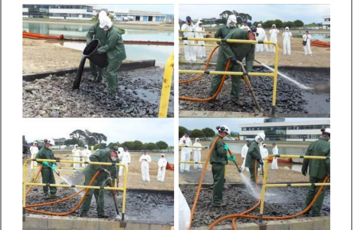
濾砂沖洗器置入礫石底部以水柱沖刷油污
