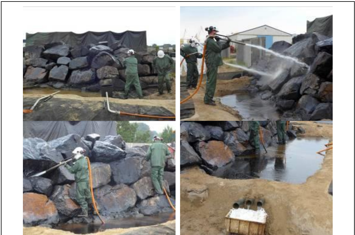
強力水柱沖刷岩石油汙示範
