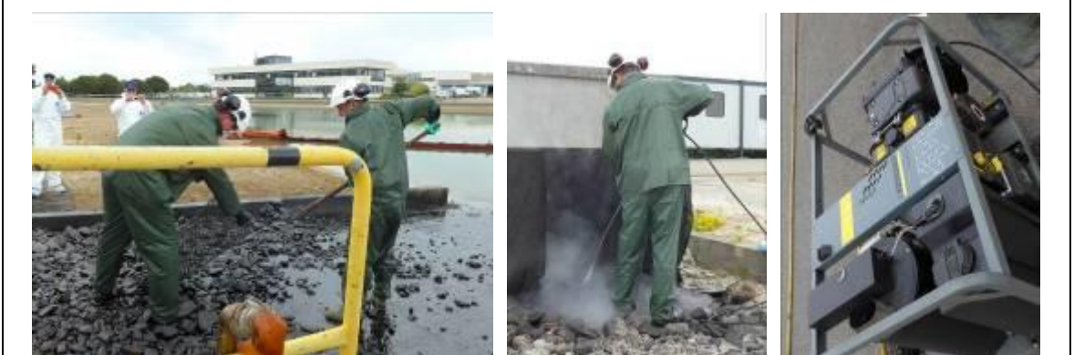
高溫高壓水槍清洗礫石
