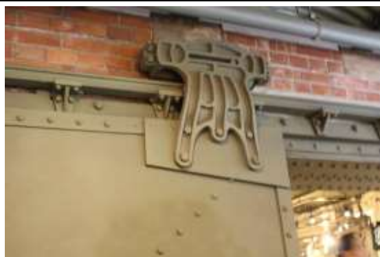
內部修復樣貌
