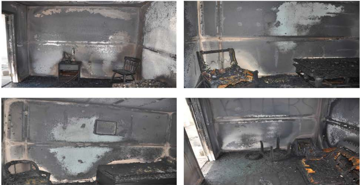
圖 17 閃燃後通風氣流所留下之燃燒痕跡(資料來源：IAAI 2015 ITC)
