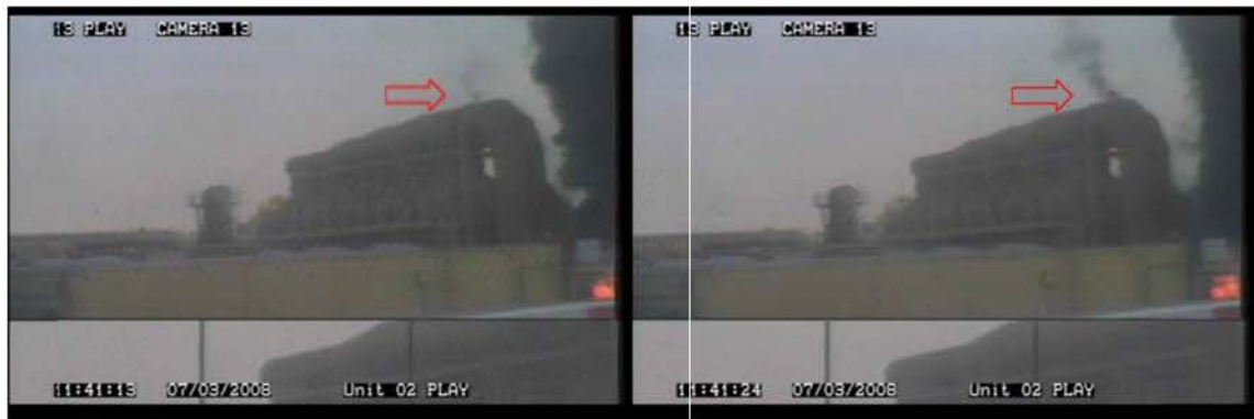
圖 14 由監視器影像發現火煙最先出現的位置在煙囪的底部(資料來源:IAAI 2015 ITC)
