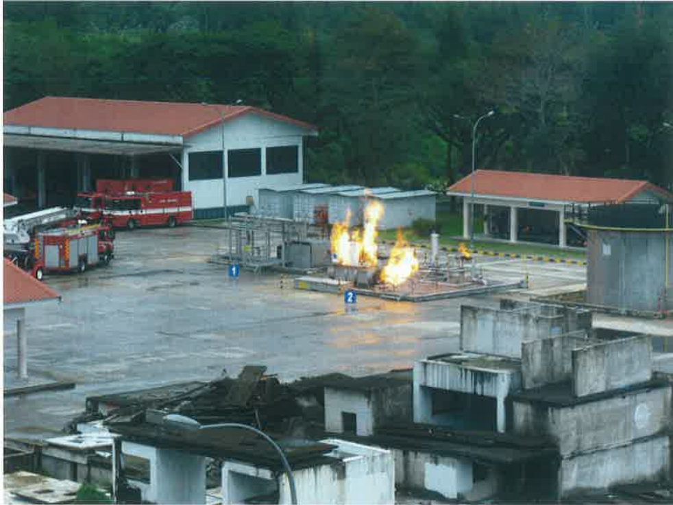
圖 2.2、臥式儲槽模擬設施（資料來源：本次參訪拍攝照片）
