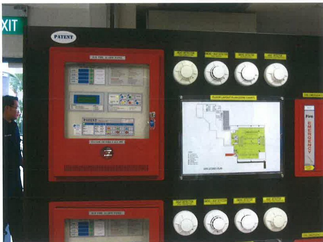
圖 2.8.2 供消防安全管理人了解各種消防安全設備及介紹火災概念之教室 (火警探測器及受信總機 1)
