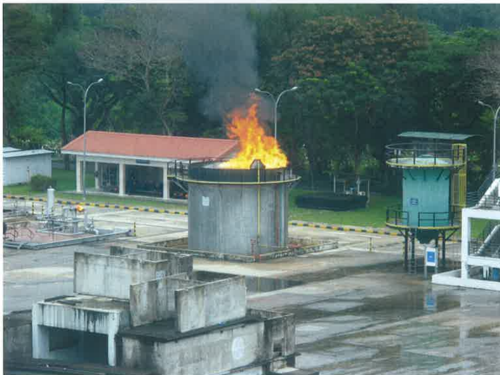
圖 2.3、儲油槽火災模擬設施（資料來源：本次參訪拍攝照片）
