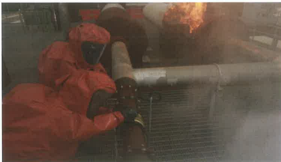
圖 2.6、化學災害堵漏訓練（資料來源：民防部隊網站）
