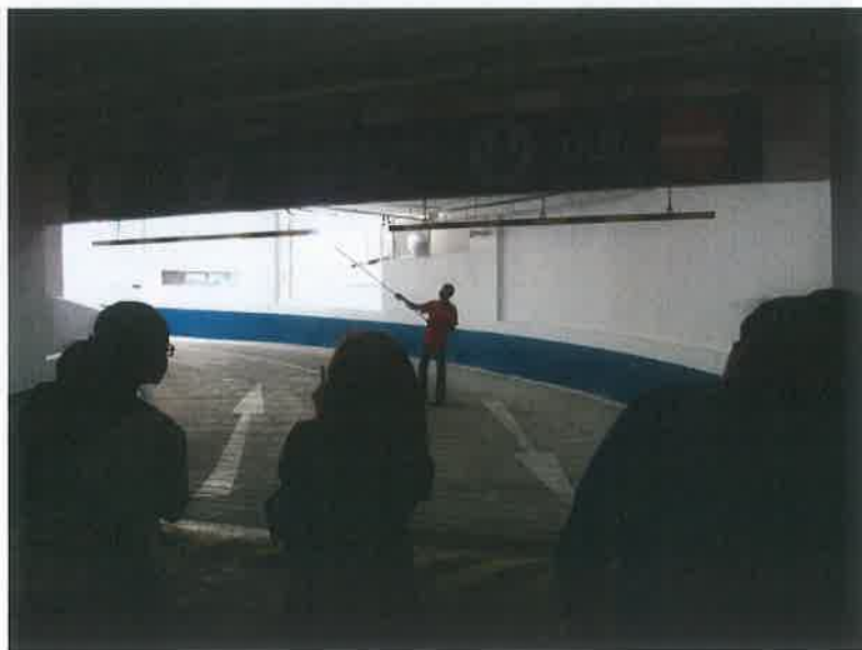
圖 30-實際測試火警警報發生時消防設備作動情形
