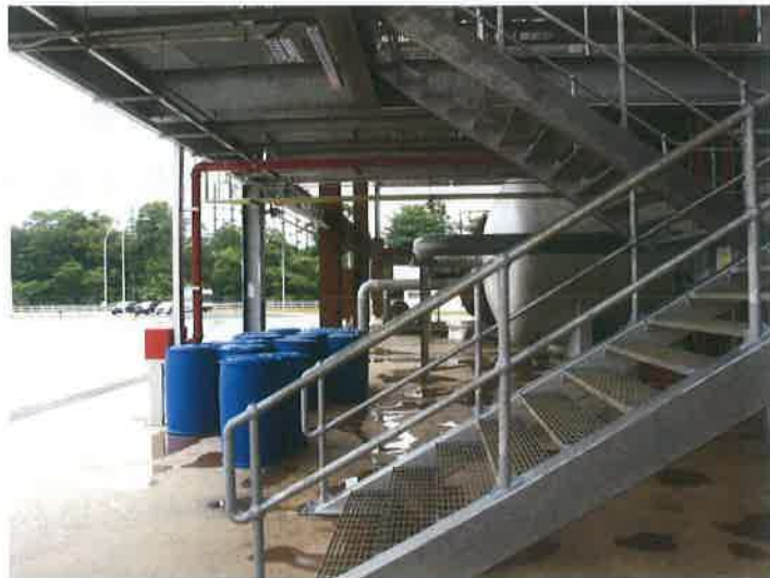
圖 58-石化工廠搶救訓練設施場景
