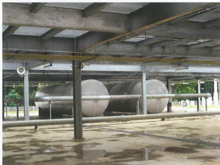
圖 56-石化工廠搶救訓練設施場景
