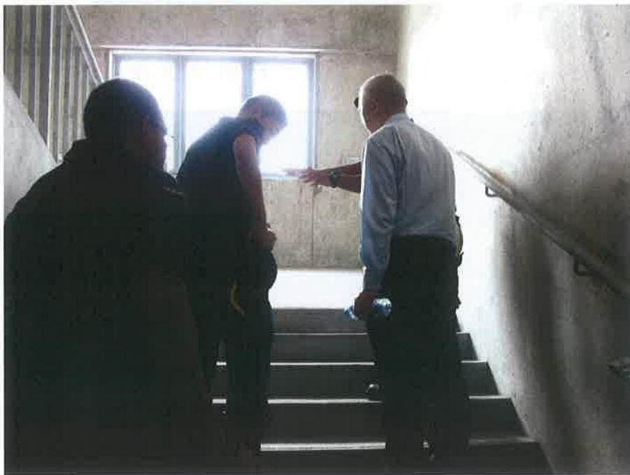
圖 45-樓梯與建築同樣傾斜 18 度
