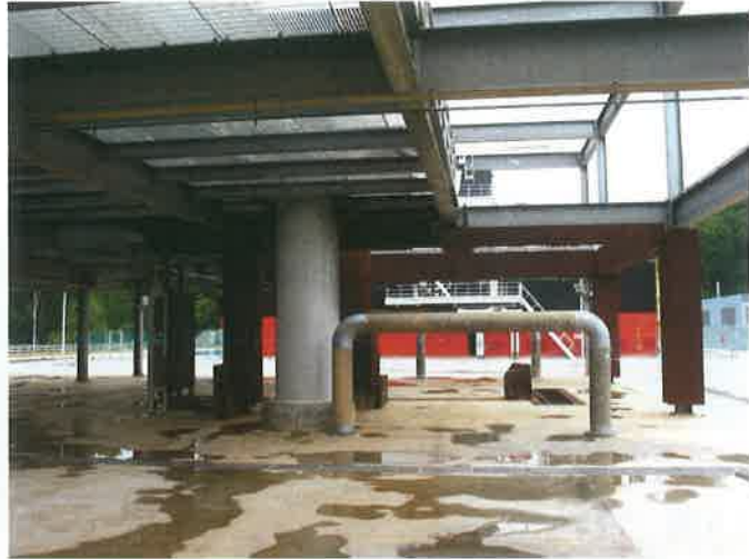
圖 57-石化工廠搶救訓練設施場景
