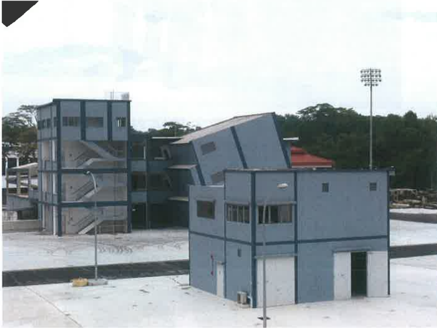
圖 44-建築倒塌訓練大樓(傾斜建築)
