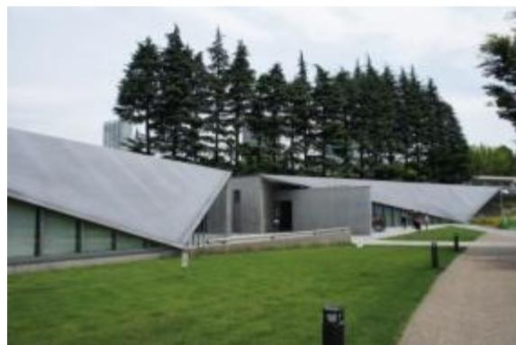
圖 31-32 主題建築物以清水模及大面積鐵板的屋頂所設計，與環境配合得恰到好處
