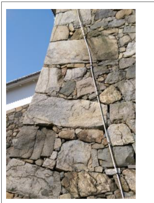
城牆修復的砌石工程
