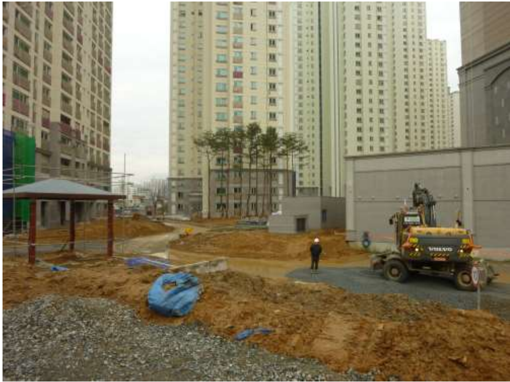
圖 1 選手村現場施工照片
