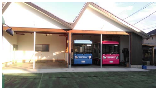
圖 20、桐生市再生館之太陽能電動公車 營運站
