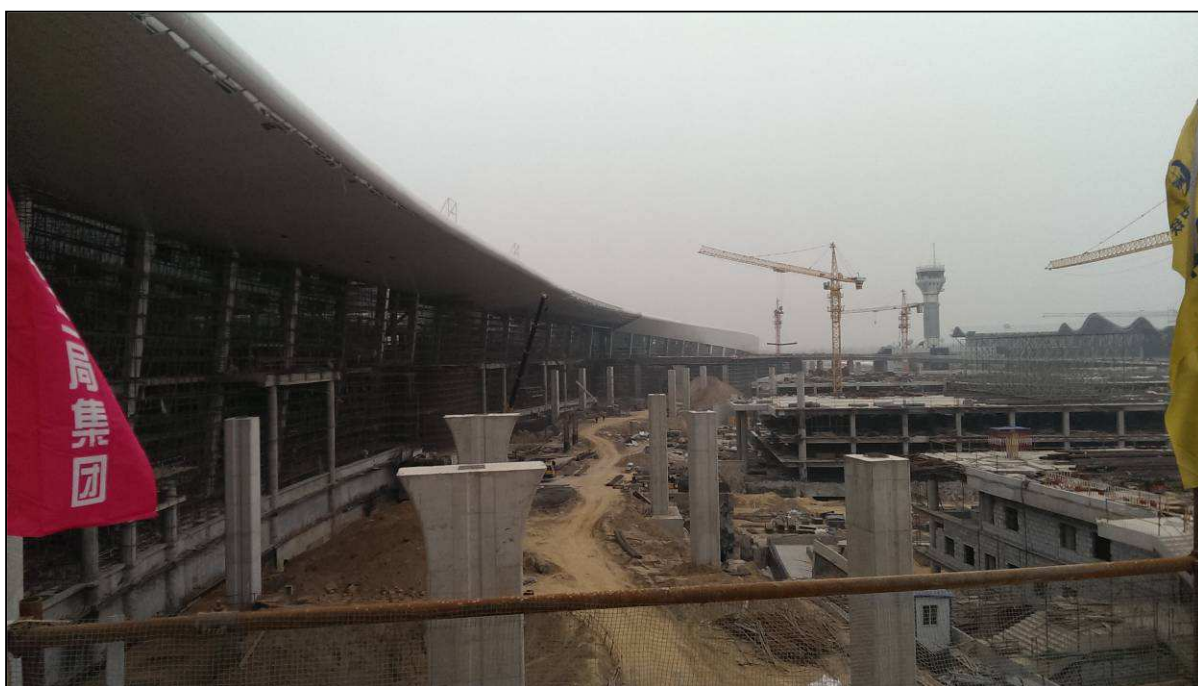
圖 4 新鄭機場二期工程-第二航站樓外觀(近照)
