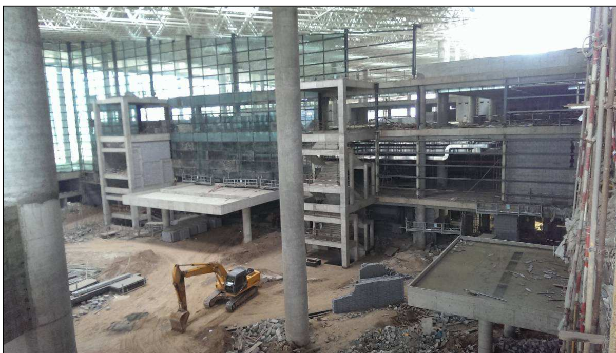
圖 6 新鄭機場二期工程-第二航站樓(內部裝修 2)
