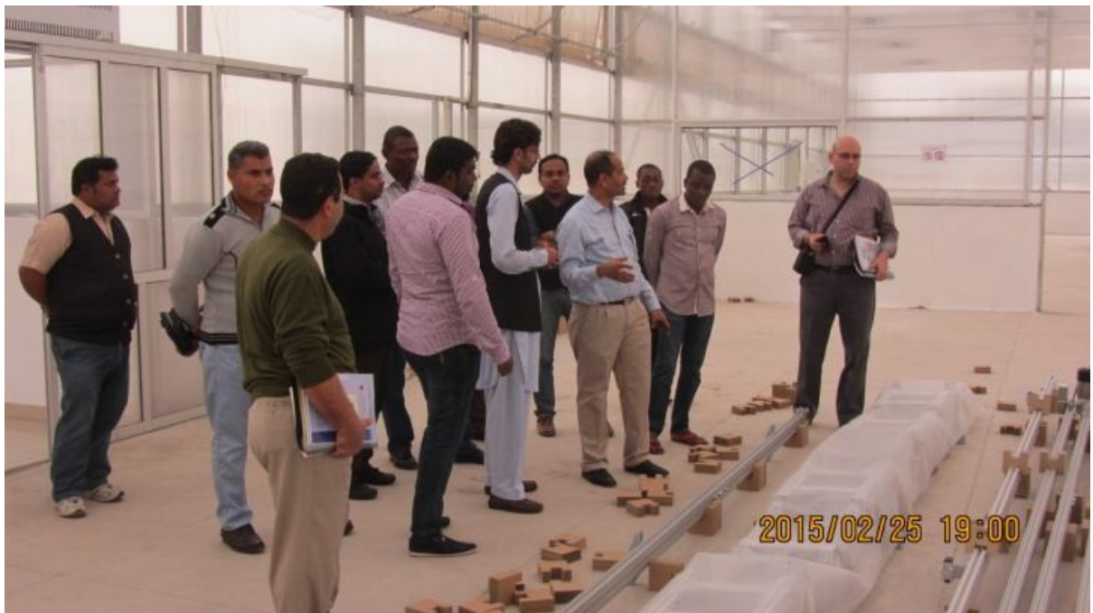
圖 14. 印度全自動植物生長監控溫室(建造中)
