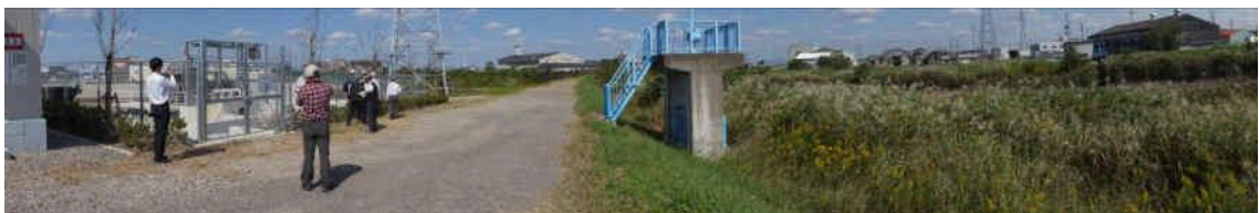
傳法寺土地聯合開發調整池之抽水機房
