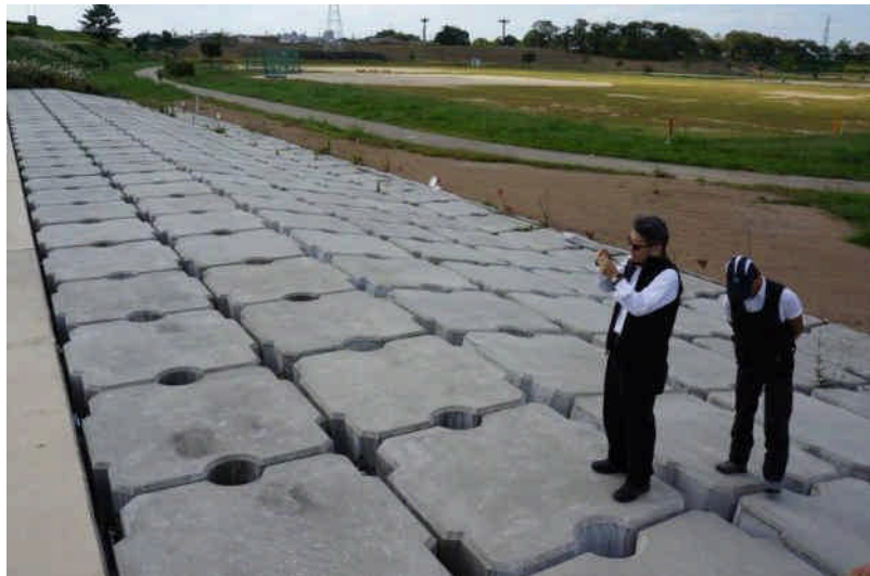
與庄內川共用滯洪綠地的護岸工
