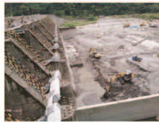
写真2 ダム直下の異常堆積(馬鞍ダム)
