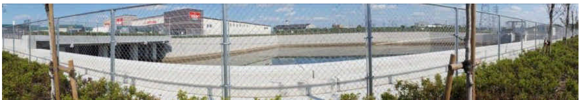
傳法寺土地聯合開發調整池
