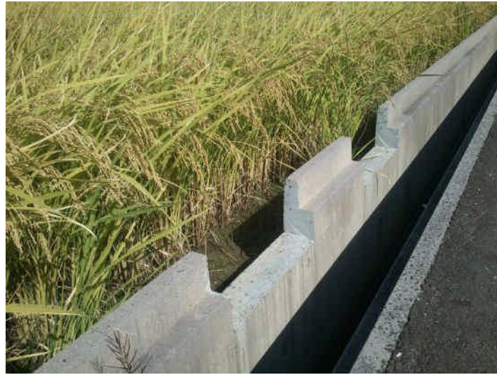
利用區排缺口的水田蓄洪
