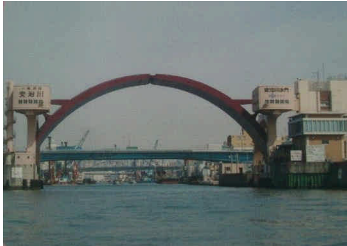
可動式防潮閘門(圓弧形)
