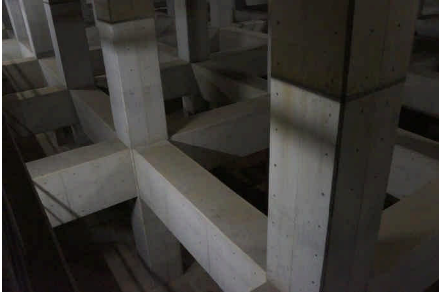
八戶里公園地下調節池
