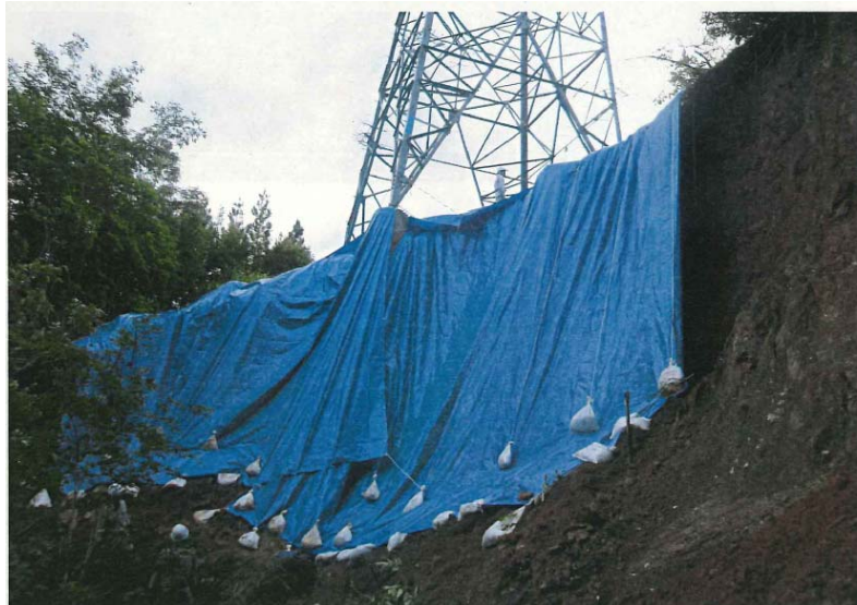
圖 4.15 邊坡保護施作紀錄 6(日本中部電力株式會社)
