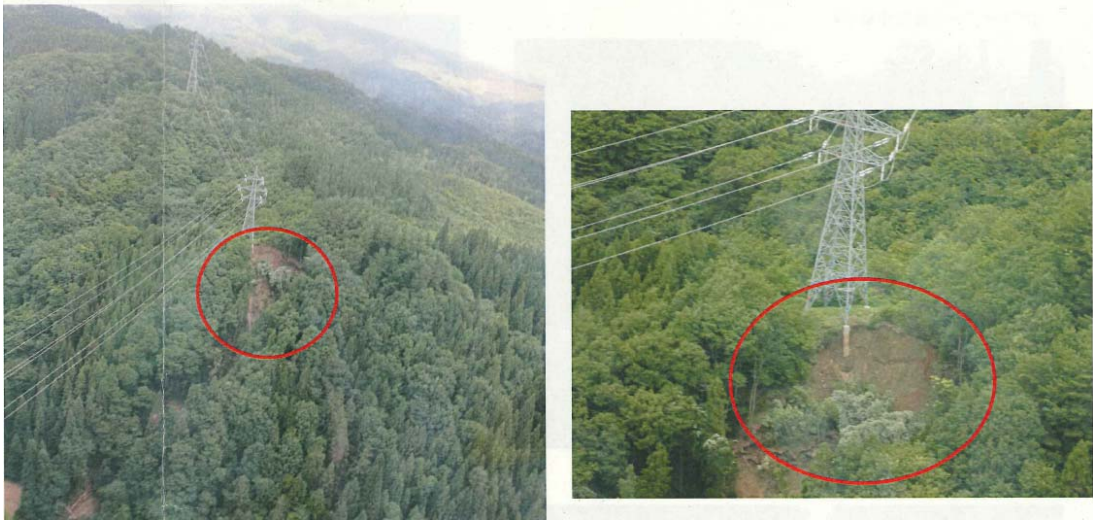
圖 4.8 塔基邊坡滑移災害空照圖 1(日本中部電力株式會社)
