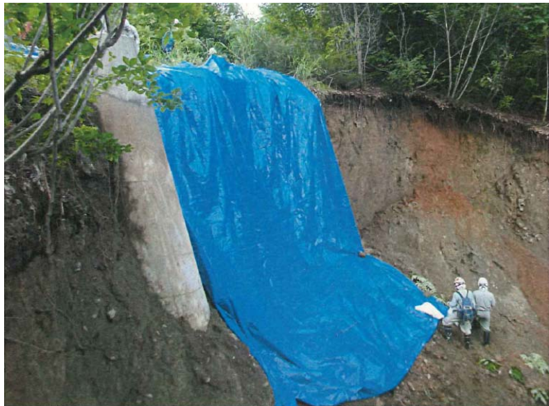
圖 4.12 邊坡保護施作紀錄 3(日本中部電力株式會社)
