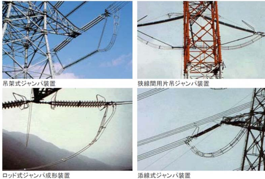
圖6.1 架空輸電線路跳線裝置(住電朝日精工株式會社)
