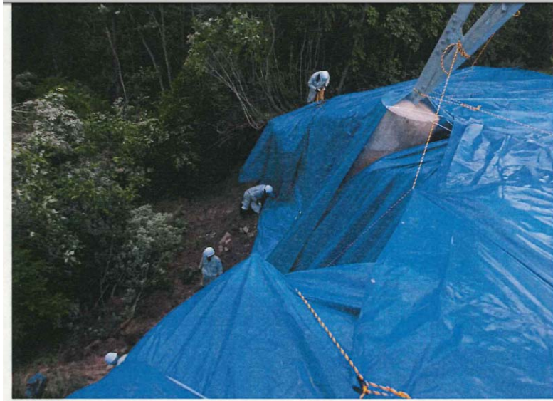
圖 4.14 邊坡保護施作紀錄 5(日本中部電力株式會社)
