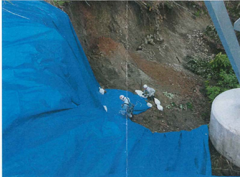
圖 4.11 邊坡保護施作紀錄 2(日本中部電力株式會社)
