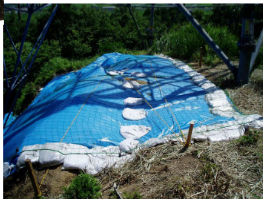
図 3.13 暫時邊坡保護作永久補強工程『不遷塔』(関西電力株式会社)
