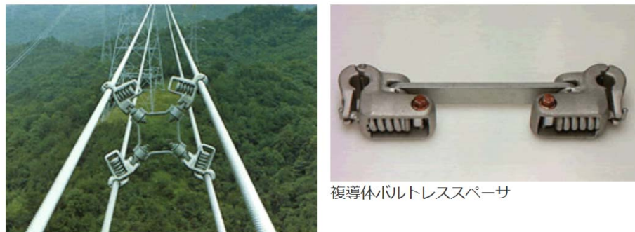
圖6.2 架空輸電線路間隔器(住電朝日精工株式會社)
