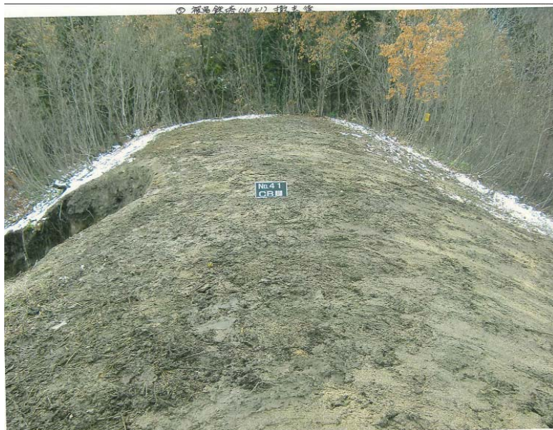
圖 4.18 鐵塔改建後現地狀況 12(日本中部電力株式會社)
