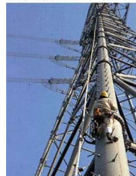
落下(墜落)防止昇降用レール取付状況
