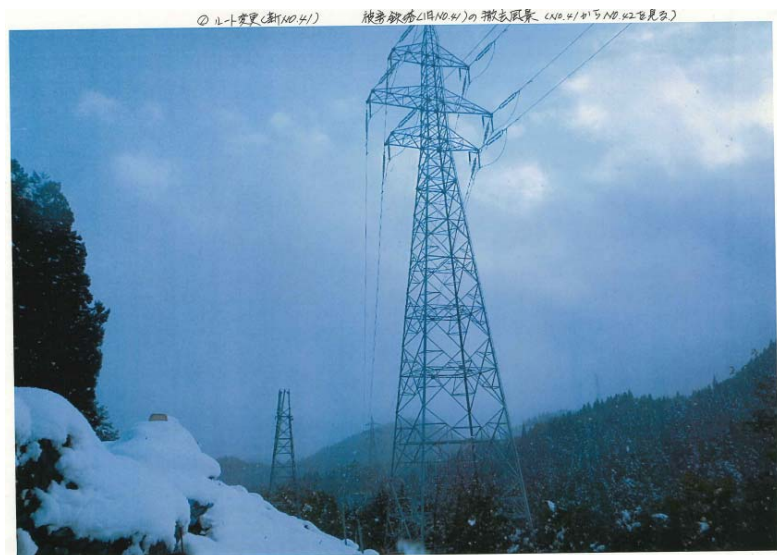
圖 4.16 鐵塔改建前現地狀況(日本中部電力株式會社)
