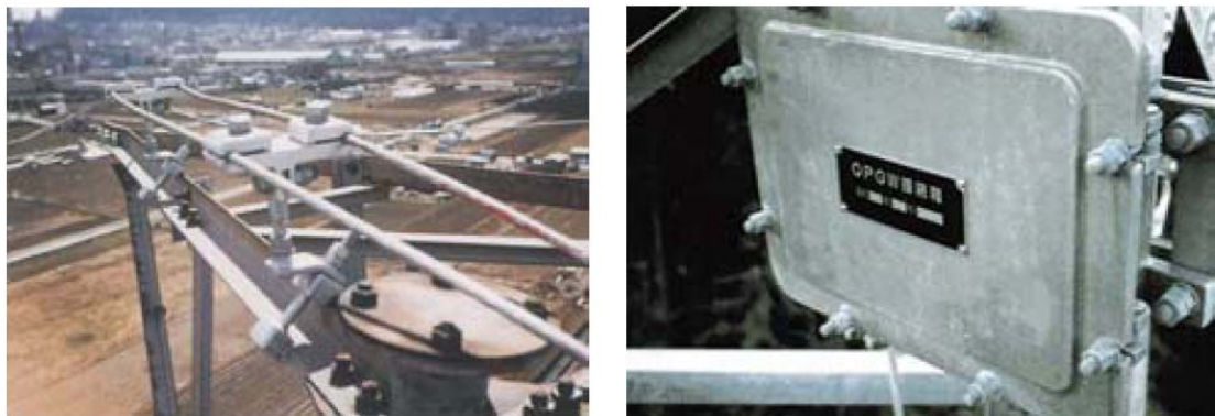
圖6.4 架空輸電線路OPGW陶瓷夾板及接續盒(住電朝日精工株式會社)
