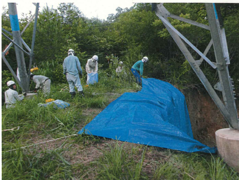
圖 4.10 邊坡保護施作紀錄 1(日本中部電力株式會社)
