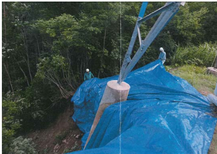
圖 4.13 邊坡保護施作紀錄 4(日本中部電力株式會社)
