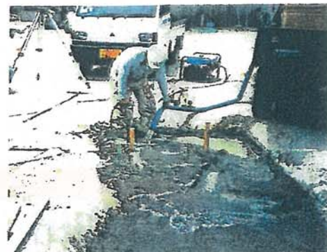
写真3 2層目の水締め
