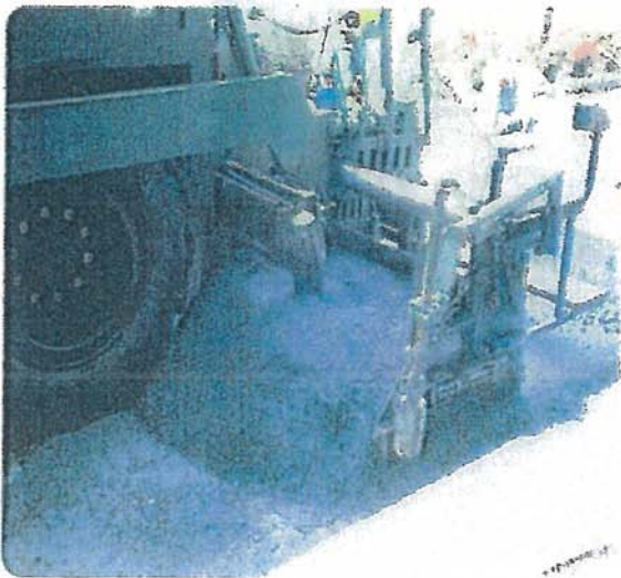
アスファルト舗装
