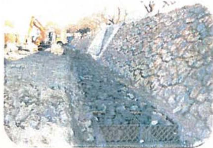
香流川: 籠マット工詰め石(割ぐり石) サイズ: 150~200mm
