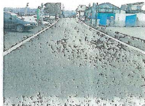
凍上抑制層実施工例(北見市 越冬後) 手前スラグ、奥側火山灰
