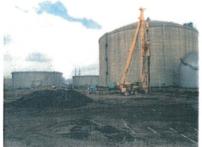
工事施工全景 (水島LNG基地)
