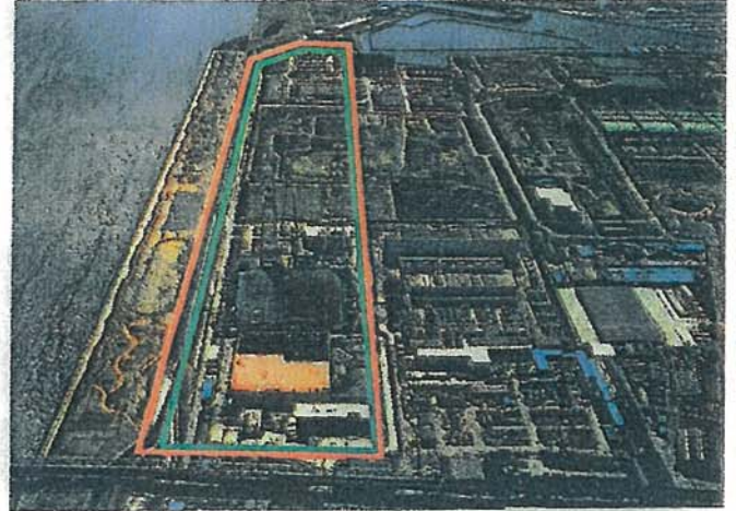
写真 新砂地区高規格堤防整備事業
