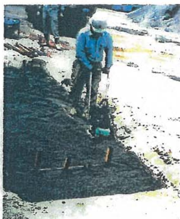
写真2 2層目タンパ転圧
