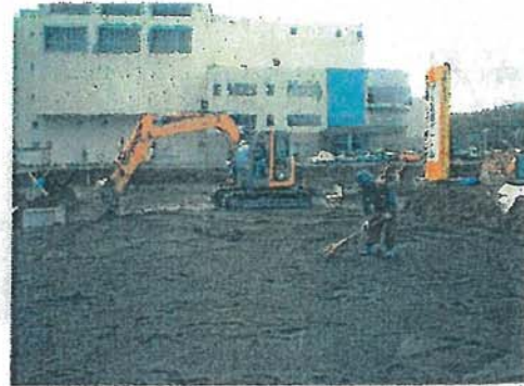
凍上抑制層の施工状況 (西いぶり廃棄物処理広域連合:マルチタワー21 隣接地)
