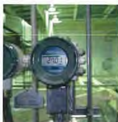
水熱酸化分解反応器圧力計
