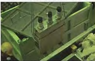
運搬容器からの取り出し
