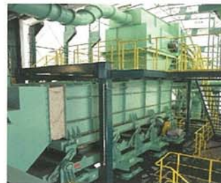
機械選別設備(1)
