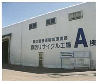
中間処理工場
