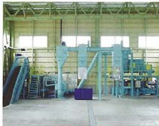
中間処理施設
