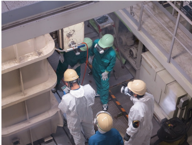
圖 12 東京 PCB 廢棄物處理設施之作業人員拆解大型變壓器情形
