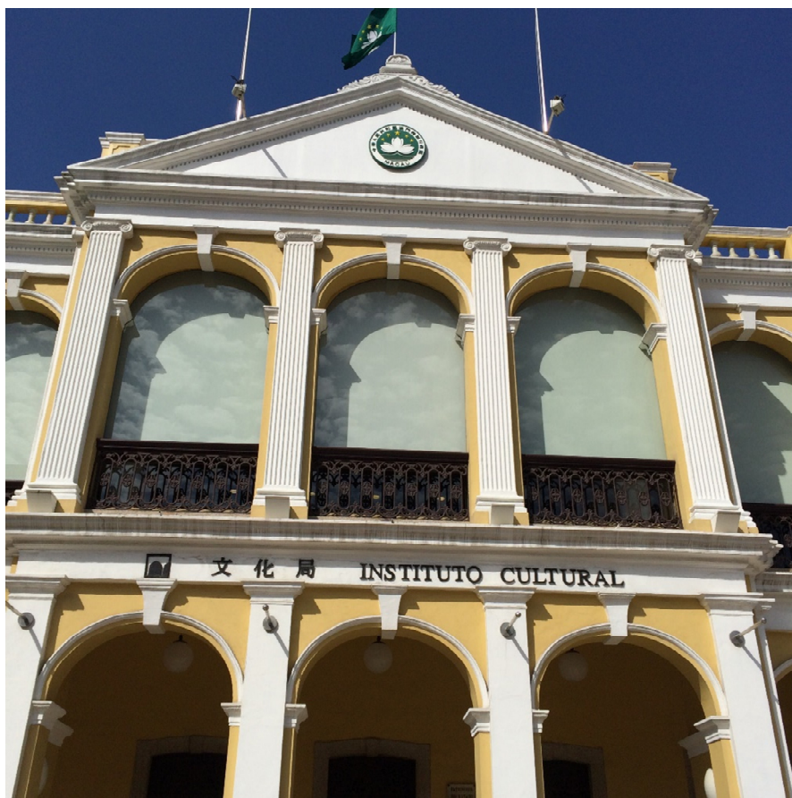
澳門塔石廣場文化局大樓 1874 年重修具明顯的南歐建築特色
