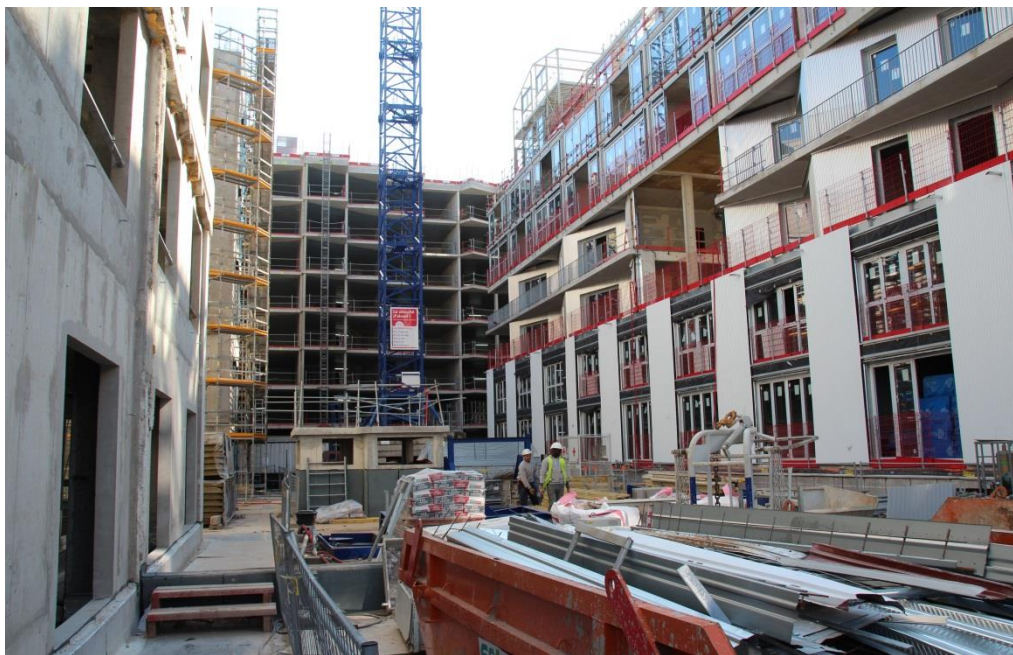
圖 32 AFEX 協會麥當勞倉庫都市更新案施工現場
