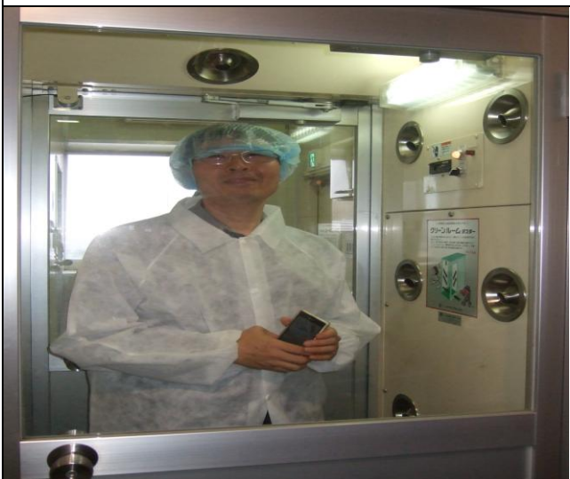
先進入空氣浴塵室除去塵埃後，才可進入碾米廠
