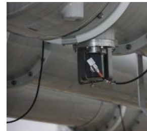
圖 12 GIS 監測 PD sensor
