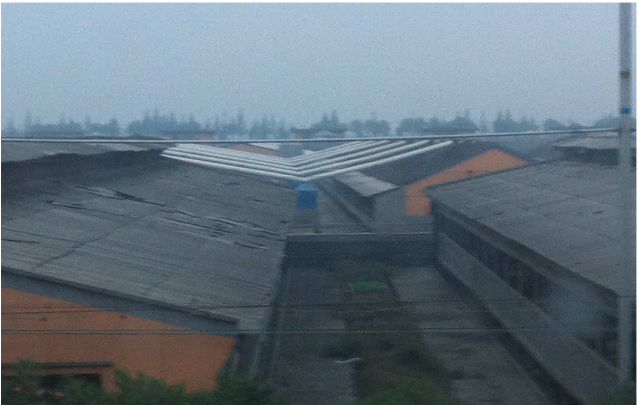
圖 11 杭州天元農業開發有限公司豬舍臭氣收集管
