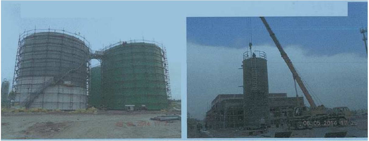
圖 3 廠內厭氧罐及相關設備施工照片
