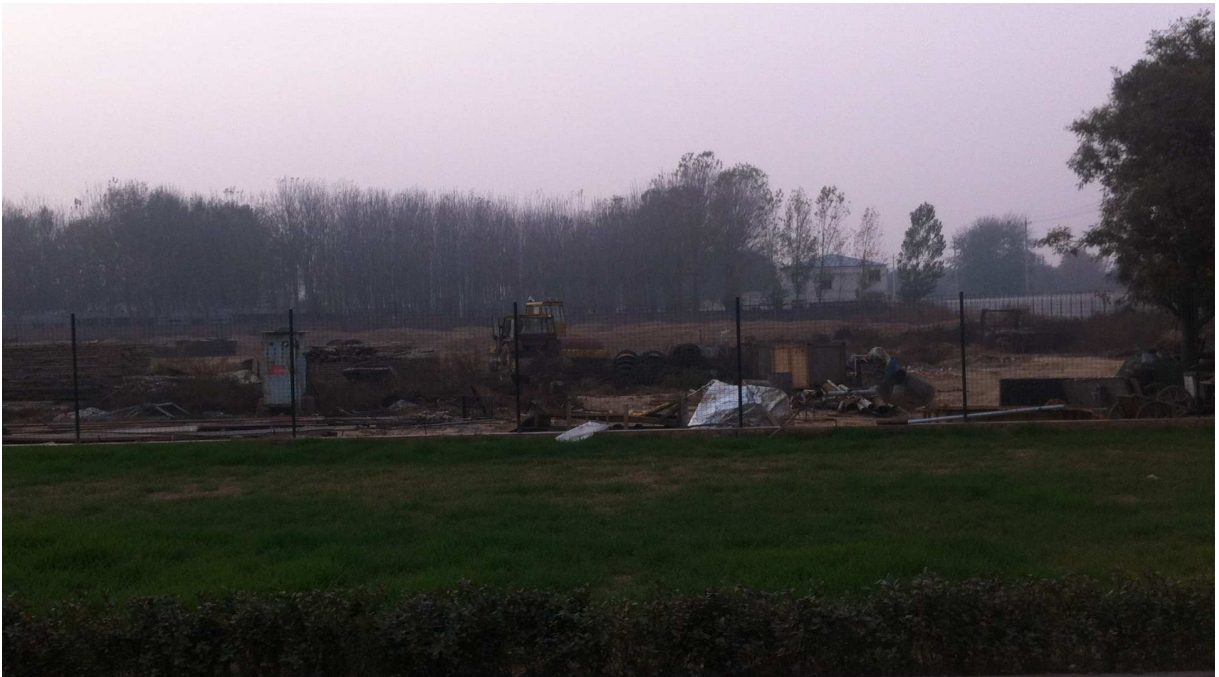
圖 8 沼渣沼液再利用區（建設中）
