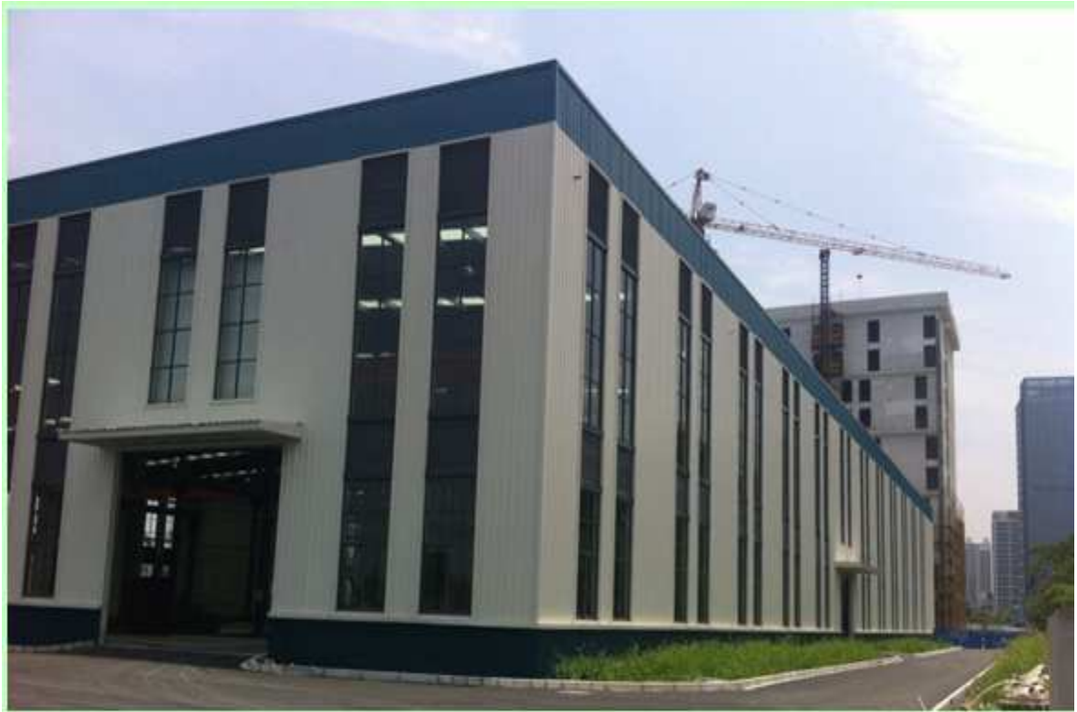
圖 33 杭州能源環境工程有限公司新建廠房外觀
