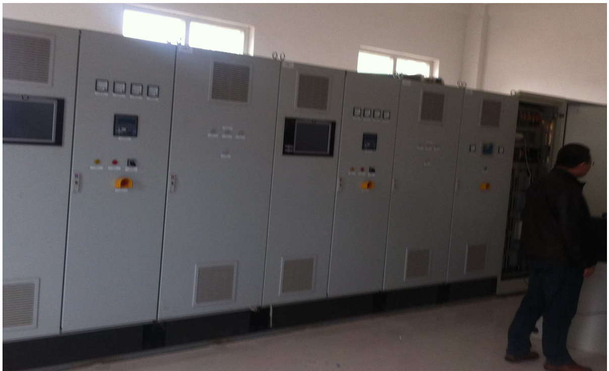
圖 6 沼氣發電機組（設置中）
