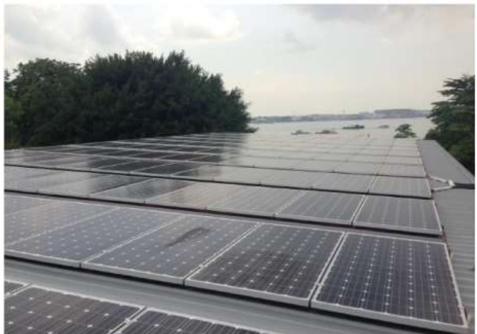
圖50 烏敏島之太陽光電的建設(2/2)
