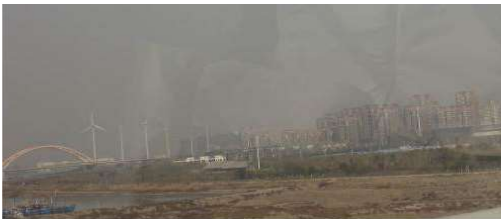
圖93 中新天津生態城的風力發電機
