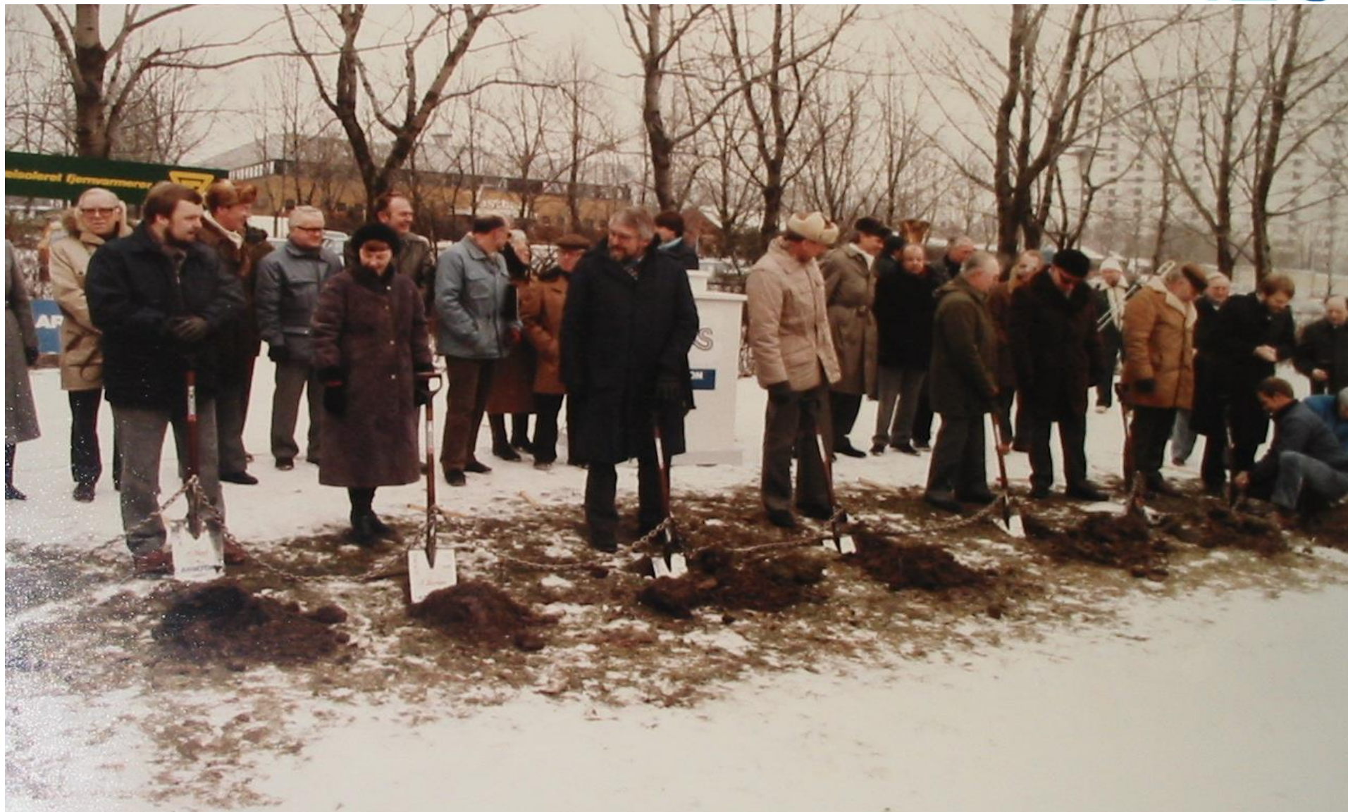
VEKS- opstart 10 · 2 · 1986 Her graves - DanThor · TuboTec lægger rørene
