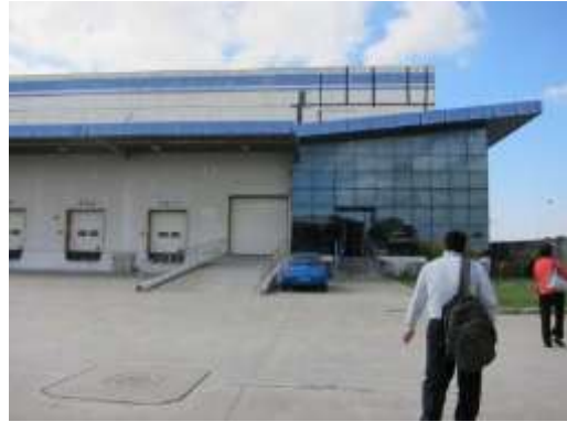
建物角隅處主要出入口裝卸月台
