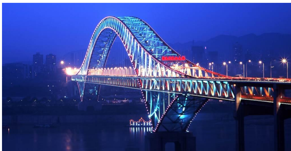
圖 5-朝天門長江大橋
