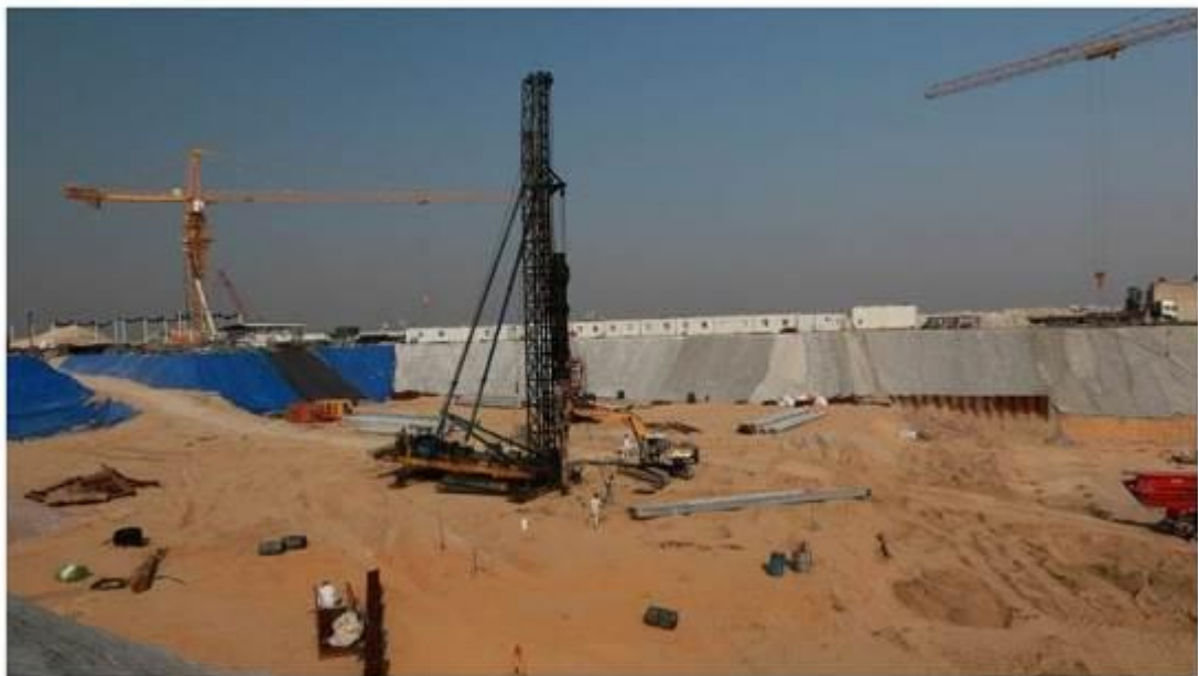
圖 41-西人工島之打入樁施工
