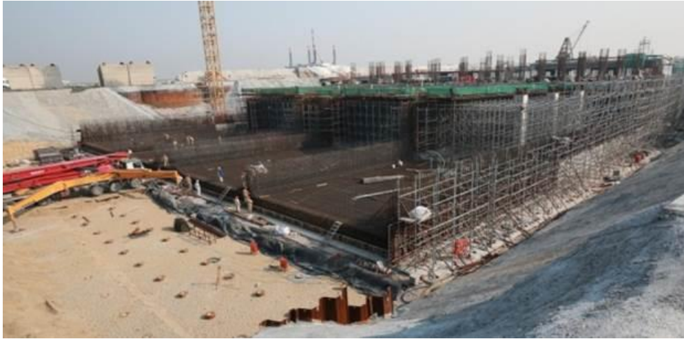
圖 42-西人工島明挖覆蓋隧道底版打入樁
