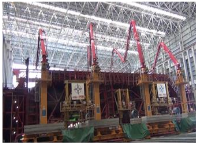
圖 33-全斷面混凝土澆置
