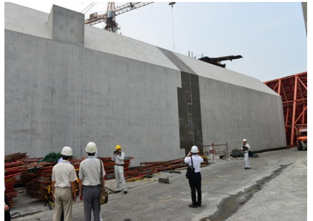
圖 35-沉埋管完成外觀
