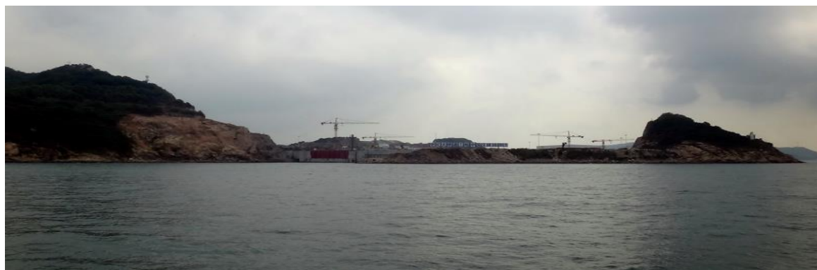
圖 27-桂山島沉管預製場
