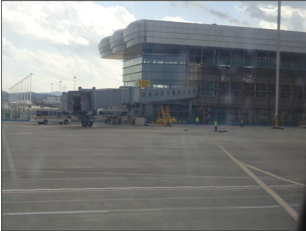
◆ 第一航站樓擴建中及空橋、機坪運作一隅
