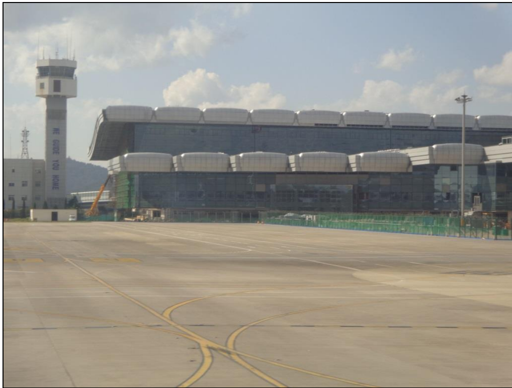
◆ 貴州貴陽龍洞堡機場第二航站樓及機坪
