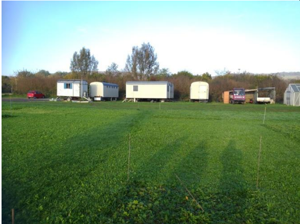
現場貨櫃屋(儀器及設備儲藏)
