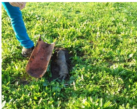
場址電線埋設管
