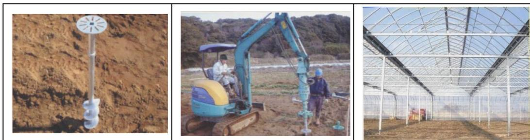
此次展覽中有多家廠商展出模組化溫室鉸管之扣環、固定器或資材，在搭建溫室時可快速組裝，同時一體化成型的設計，有助於承受重量(或壓力)的抗性。在日本冬季有積雪問題，溫室在設計或測試時，溫室結構(尤其是頂部)對於重量的承受力需注重，使用廠商研發之固定環所建造之溫室，在用砂包測試對於重量的承受力，以溫室結構變形量作為指標，可清楚顯示使用固定環後之效果。但並無我們較關心之抗風力測試方法，雖然特殊固定環的使用，對於抗負重或風壓應有相近的效果。
