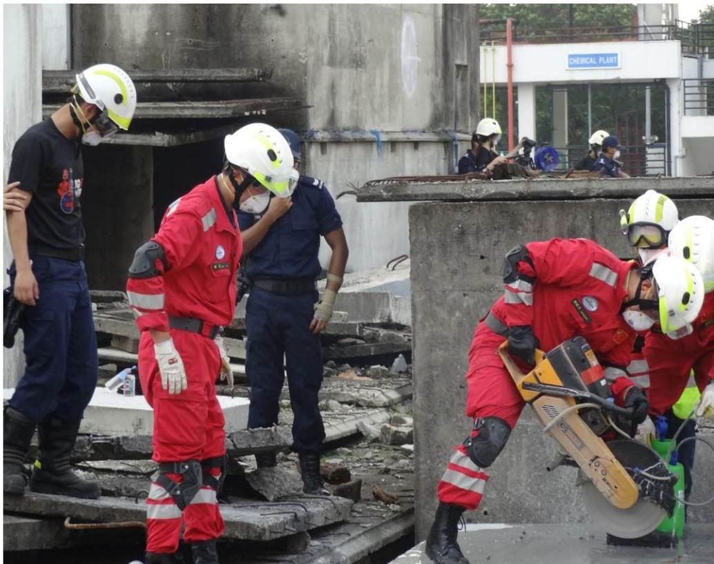
圖 39：鋼筋混凝土圓盤切割器，應提高全轉速再入刀避免傷害鑽石刀面。
