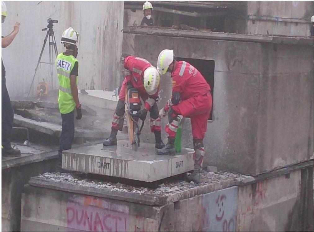
圖 38：切割深度操過 20 公分無法切穿。冷卻水單面冷卻未接上預設管路。
