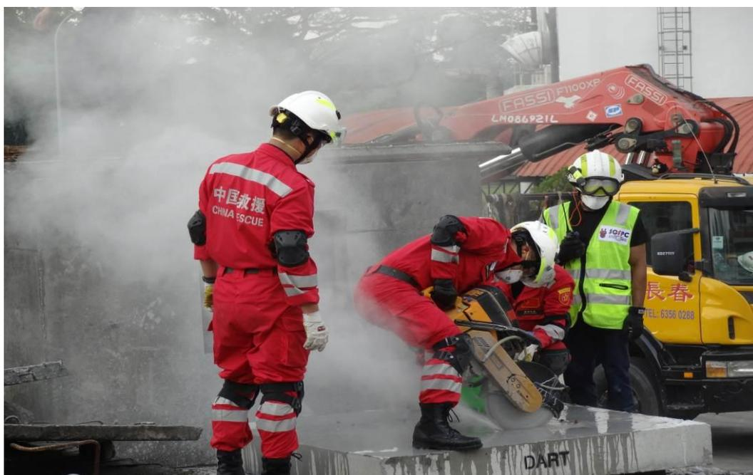
圖 11：鋼筋混凝土切割方法與技術練習
