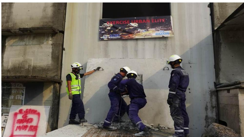
圖 13：電動削岩機操作練習。
