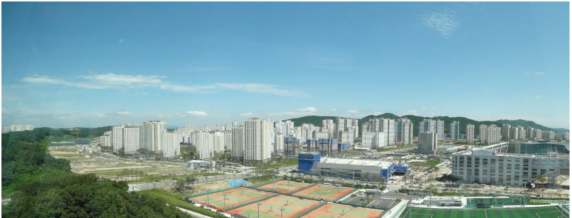
韓國新行政中心市_世宗市建設
