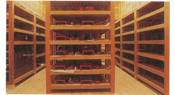
漆器収蔵庫 壁・天井 = スプルース仕様 棚仕様 = b
