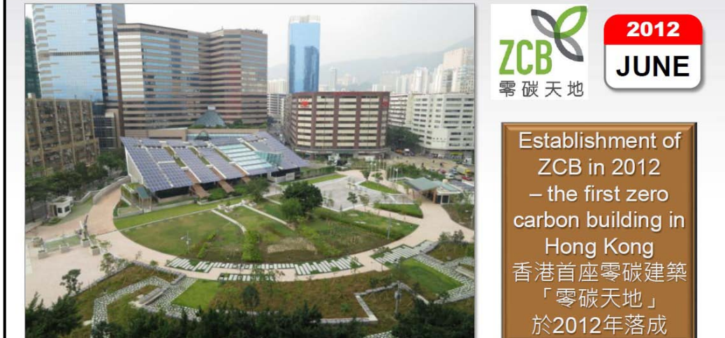
圖 5 香港建造業議會完成首座零碳建築
