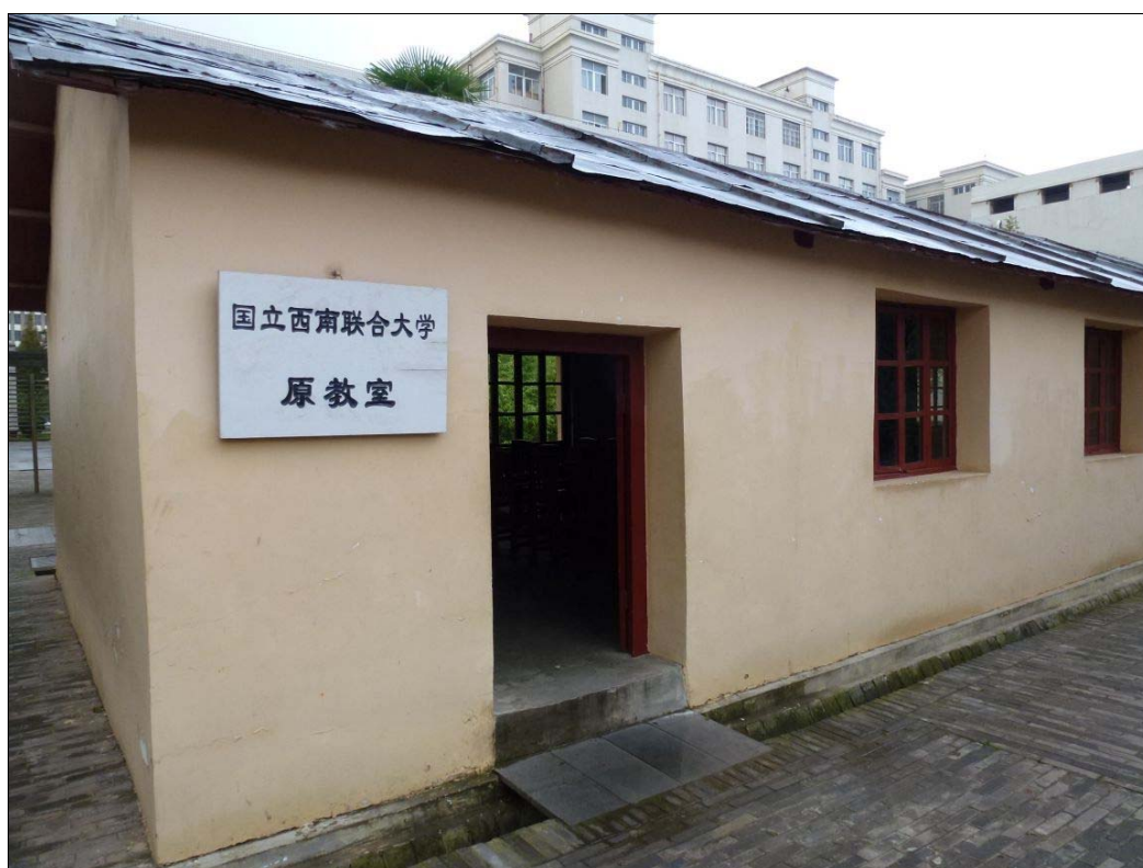
圖 2 國立西南聯合大學舊址鐵皮屋頂教室
