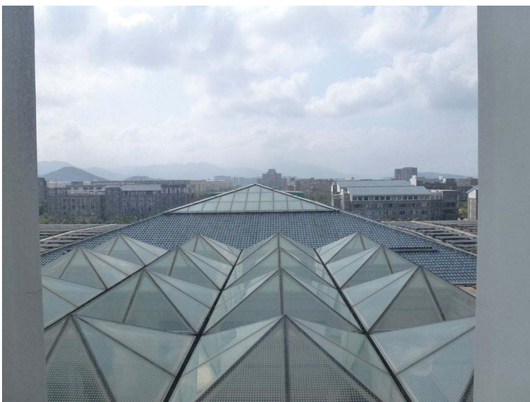
圖 6 總圖書館部分屋頂設計採光罩引入自然光源
