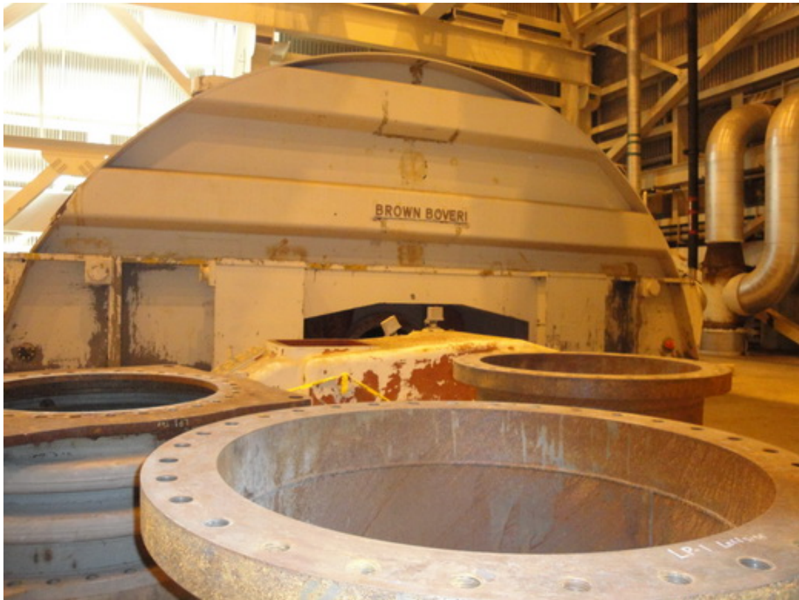
低壓汽機蒸汽管段拆下後不再回裝
