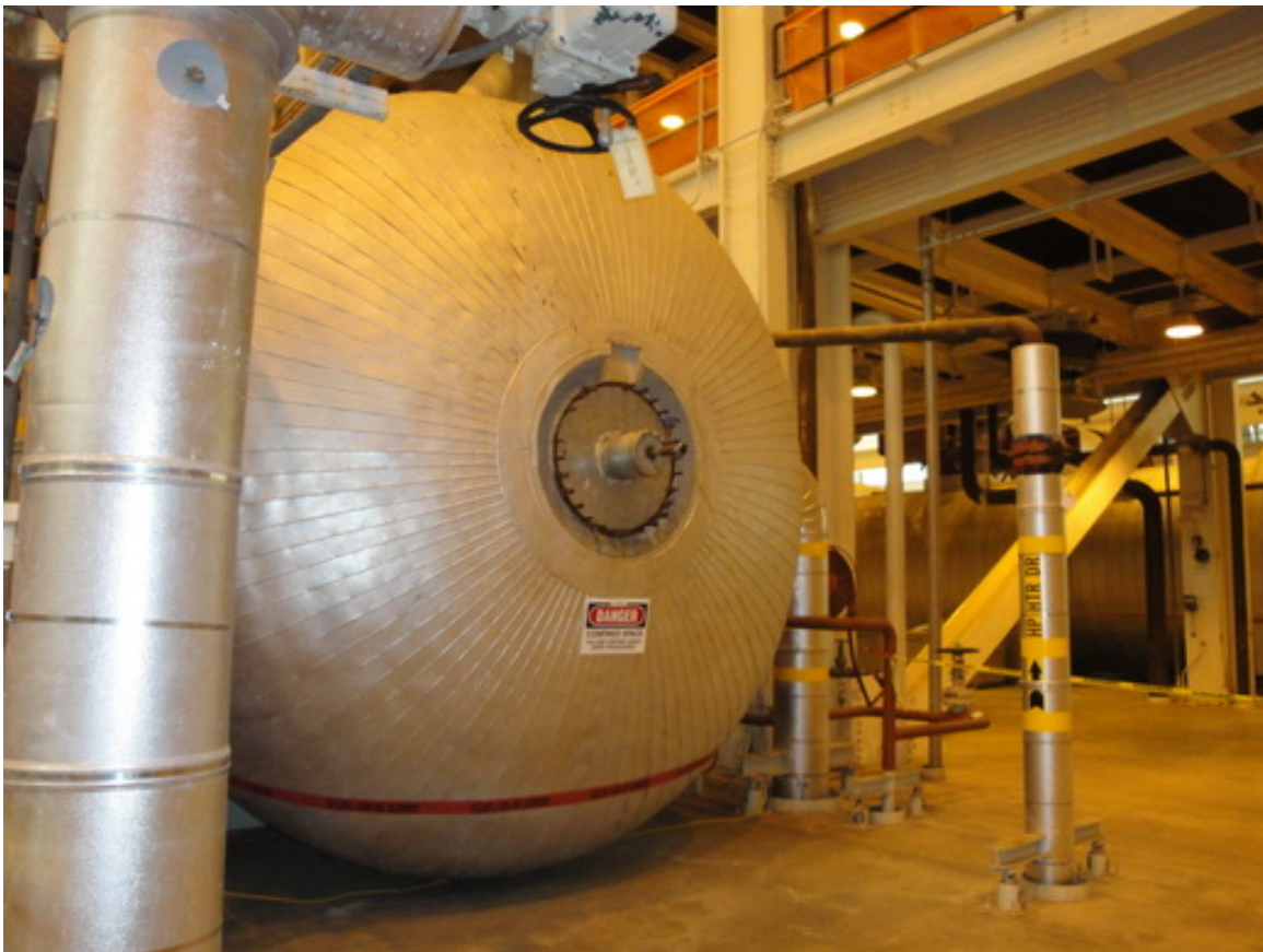
MSR 原來外接乾燥空氣進行封存，現已拆除
