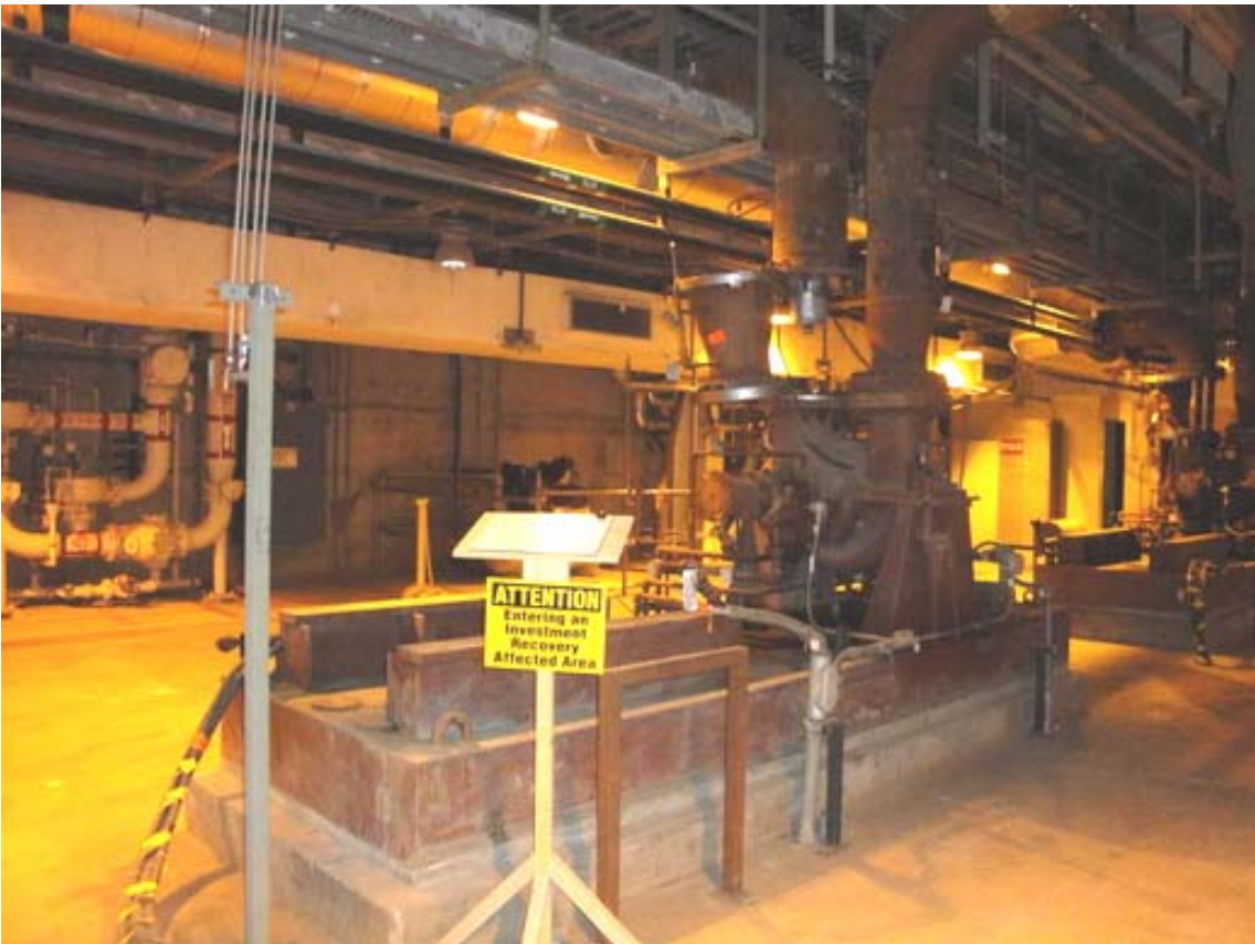
原址之 Condensate Booster Pump (CBP) 已拆除轉供友廠使用
