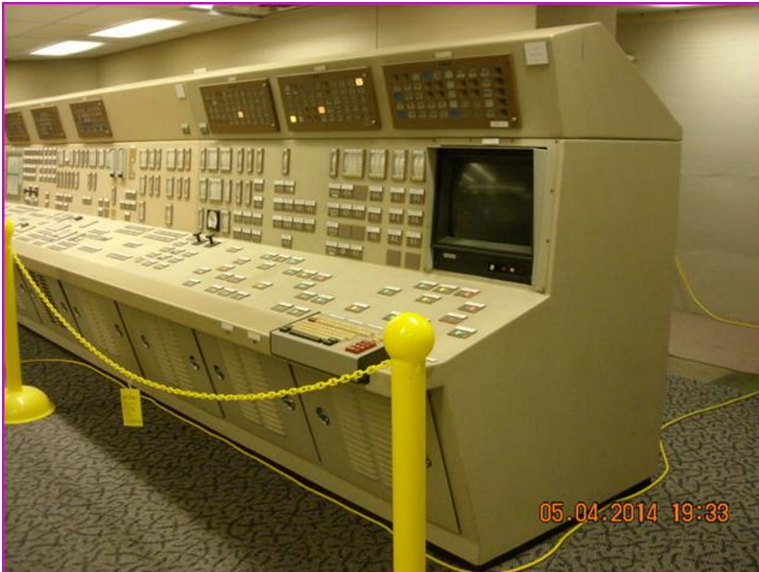
控制室唯一仍保持監控的僅剩消防監視盤
