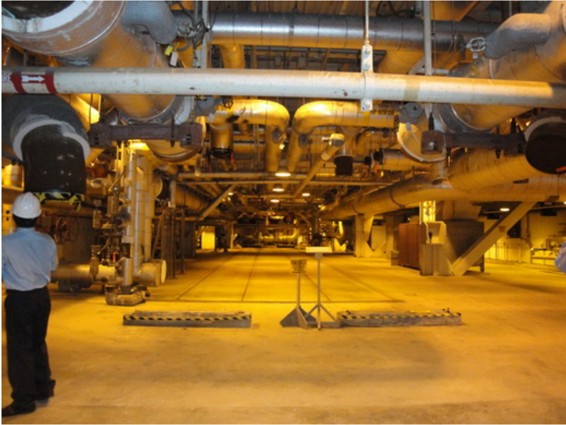
原址之飼水加熱器已拆除轉供友廠使用
