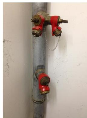
圖 24 消防栓出水口(外露式)
