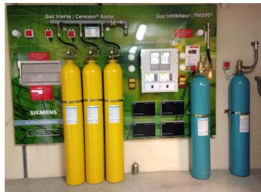
圖 6 氣體滅火設備操作盤
