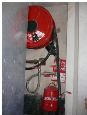
圖 23 管盤式消防栓(收納式)
