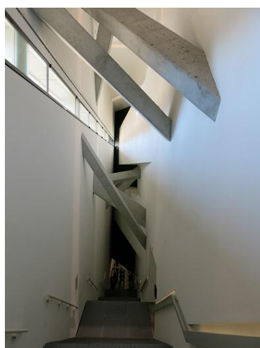
階梯上方的斜切樑柱 產生壓迫感
