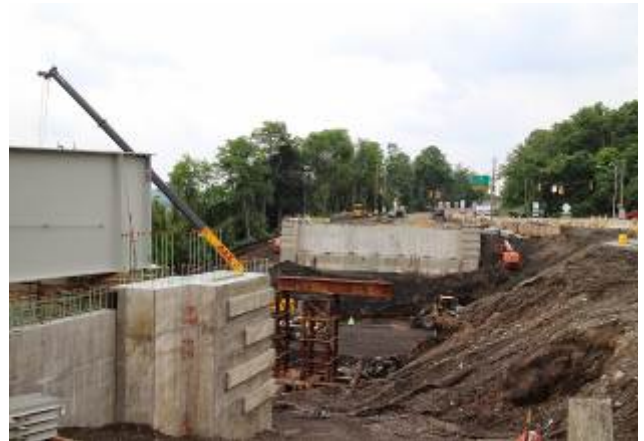
改建中橋梁施工照片
