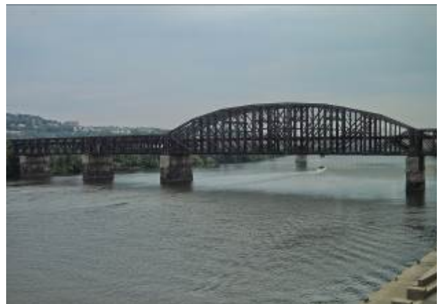
位於羅倫斯會議中心旁鐵路鋼橋
