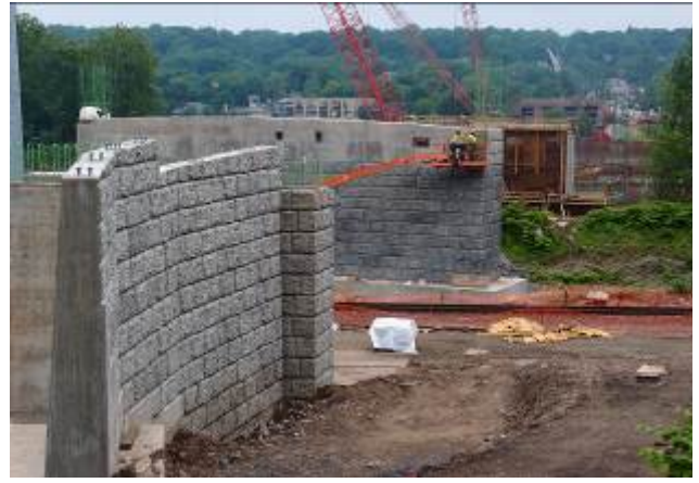
改建中橋梁施工照片
