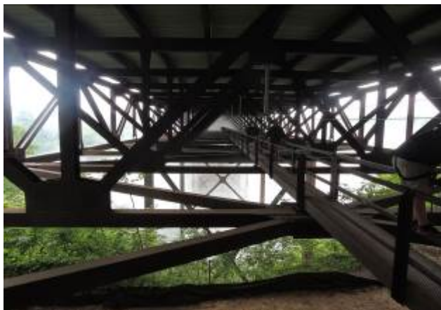
新河峽大橋檢修步道
