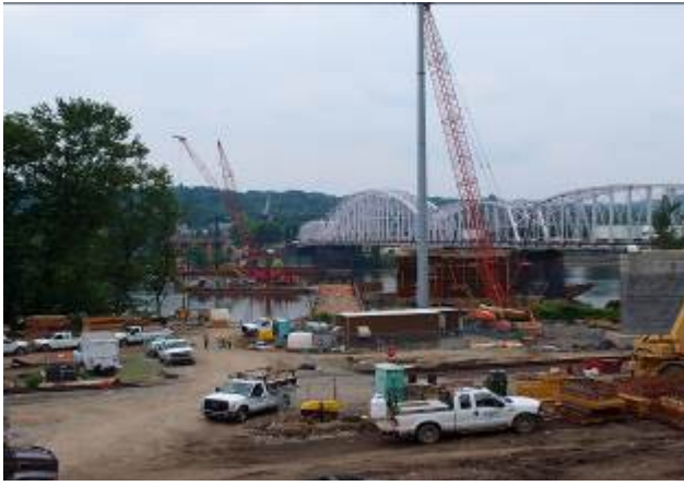
改建中橋梁施工照片
