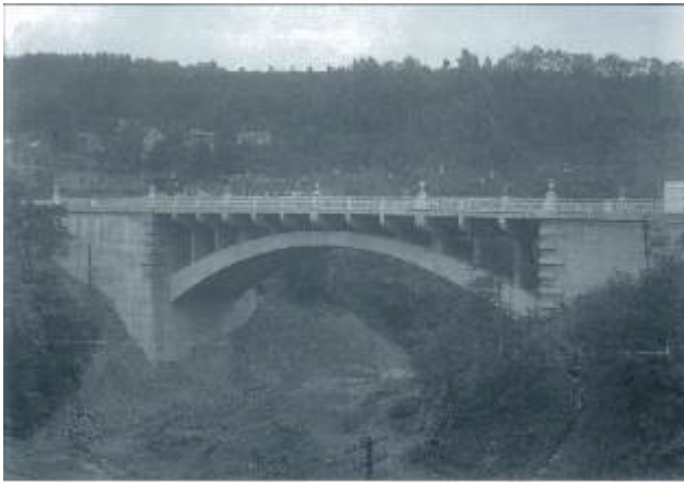
1914 年完成時舊橋照片
