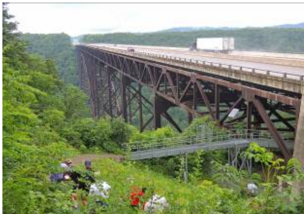
新河峽大橋檢修步道
