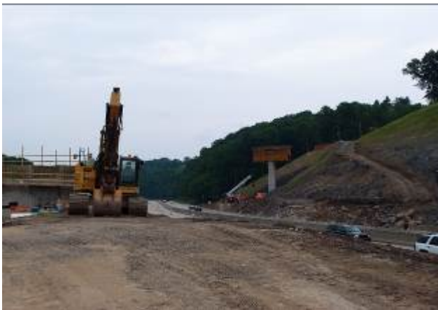
改建中橋梁施工照片
