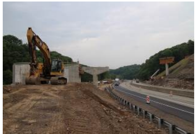
改建中橋梁施工照片
