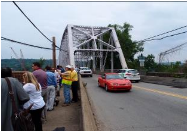
百年歷史的桁架鋼橋
