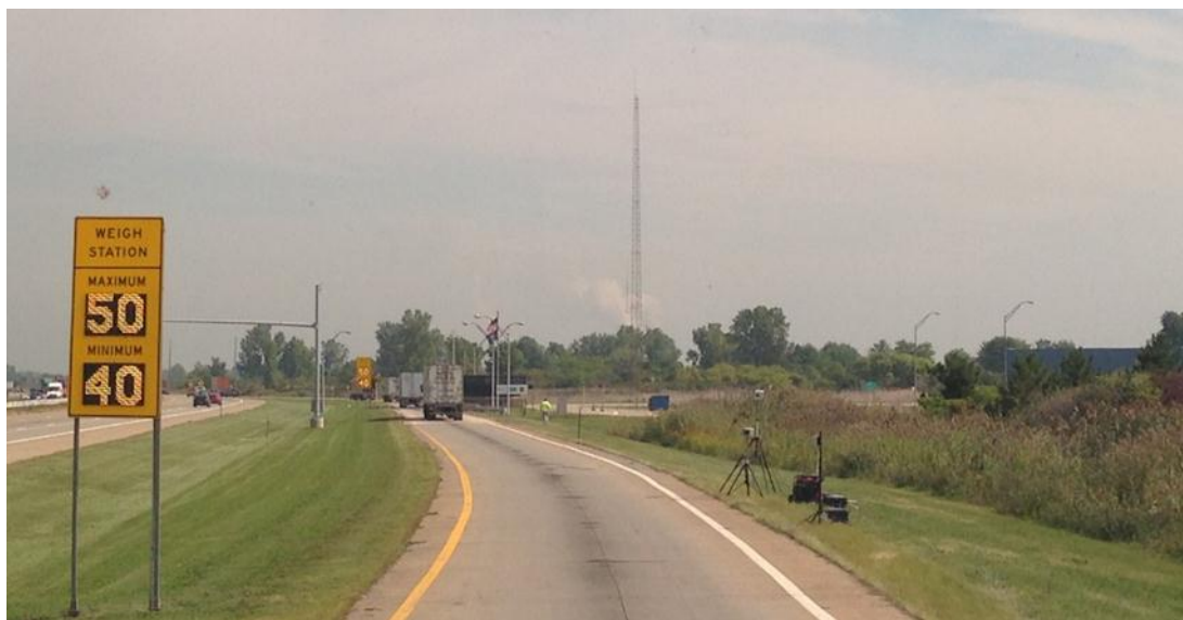
圖 22 進入磅區前之可變速限標誌(左側)及車牌辨識攝影(右側)
