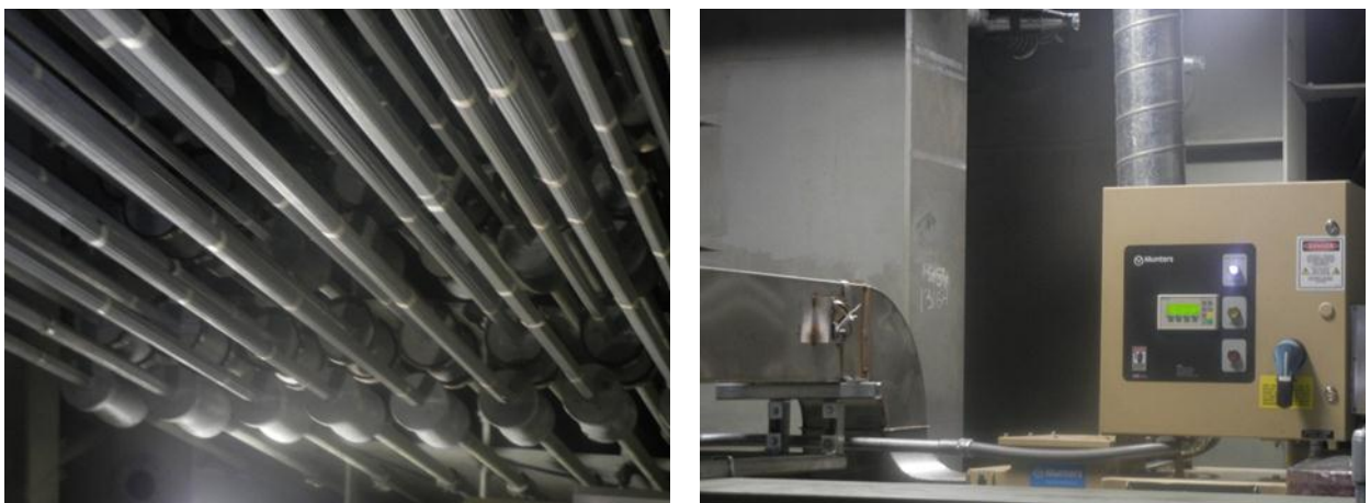
圖 49 新海灣大橋箱涵內部鋼索及除溼設備
