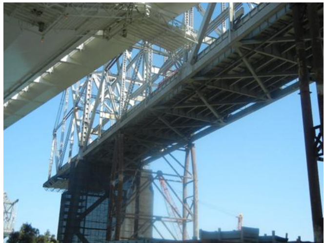
圖 46 舊海灣大橋拆除現況
